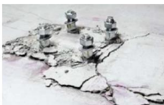
Выкалывание бетонного основания за анкером
