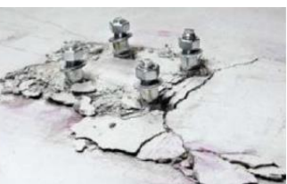
Выкалывание бетонного основания за анкером
