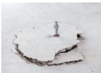
Комбинированное разрушение по контакту анкера с основанием и выкалыванию
